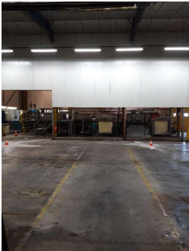
Photographie 4 : Bacs de traitement de surface
